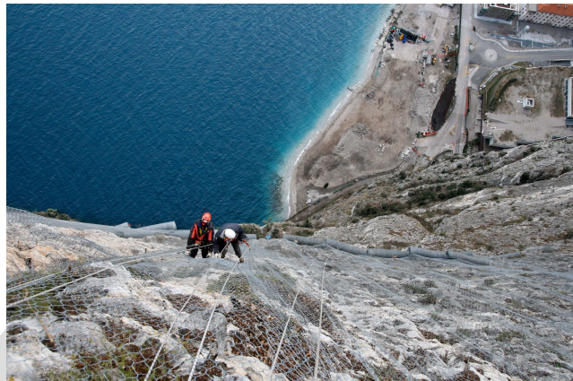
Figure 1: Exemple de grillage plaqué en protection de falaise
