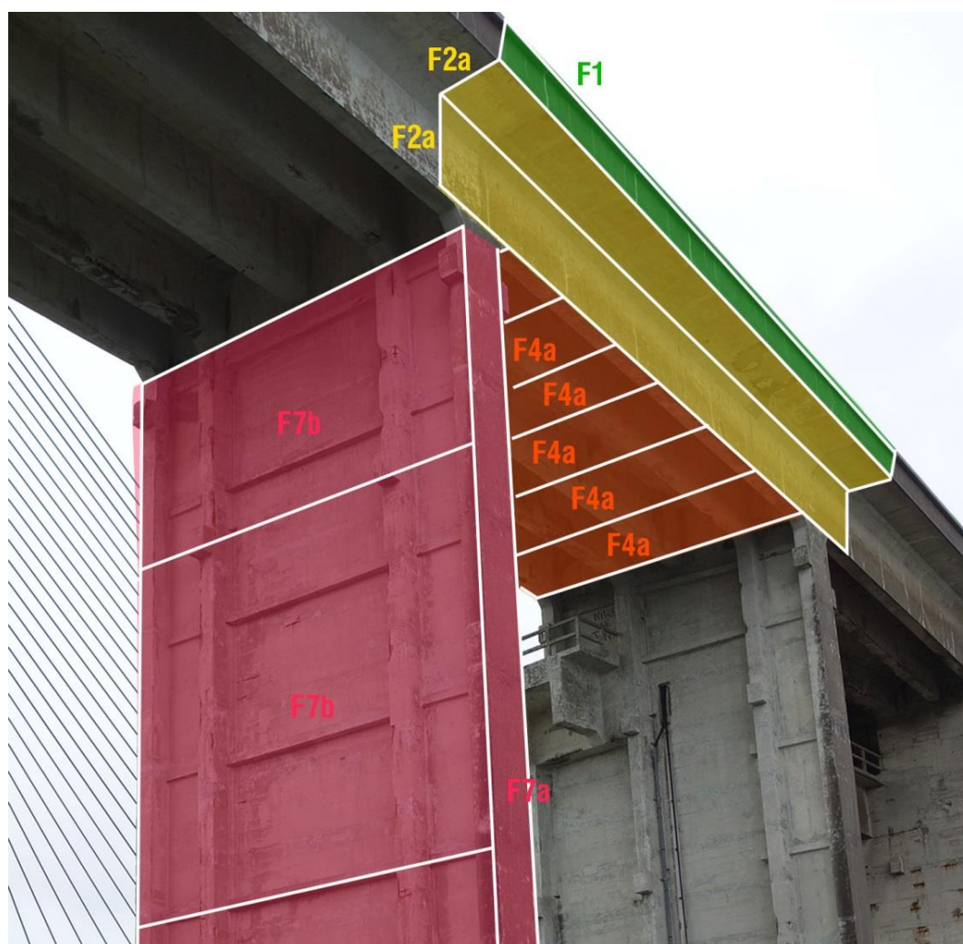
Principe de pose des filets F4a sur le tablier routier et sur piles
