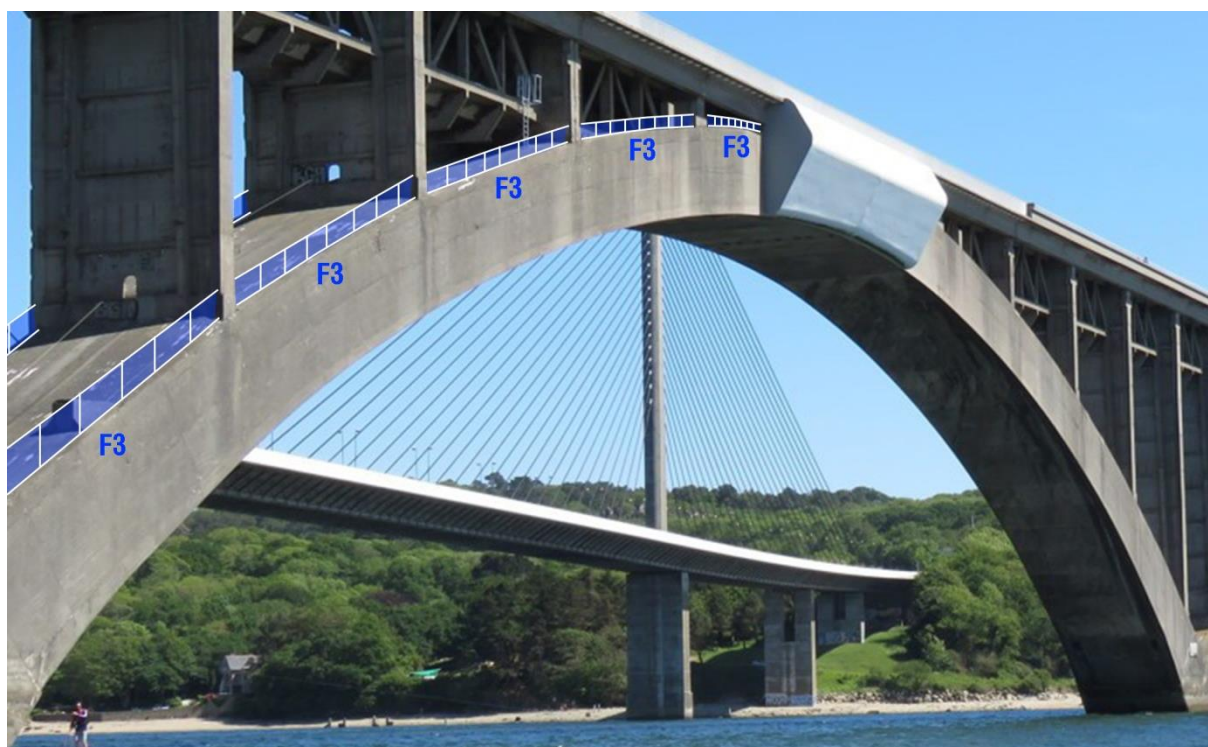
Principe de pose des filets F3 sur les arcs entre palées
