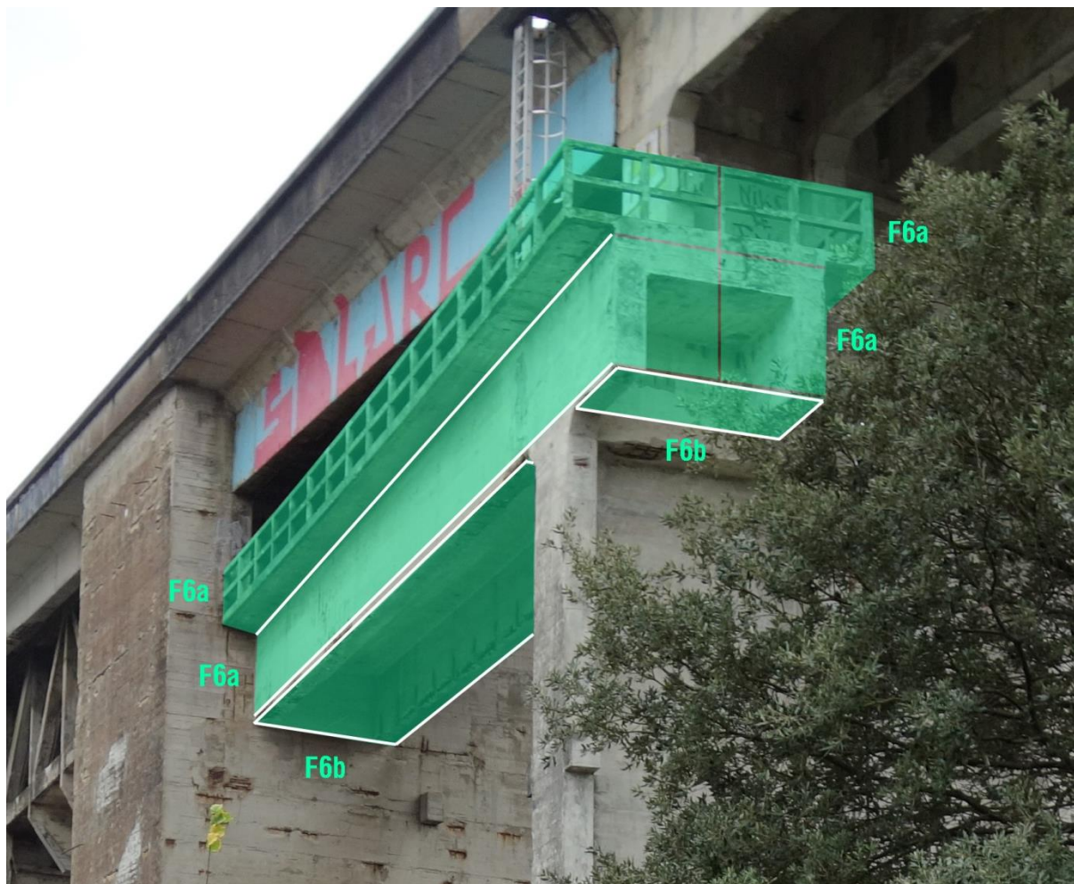
Principe de pose des filets F6 sur l'extrémité du tablier ferroviaire
